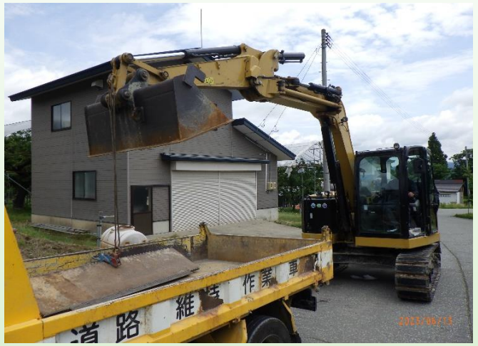
■ 新しい鉄板蓋の設置
