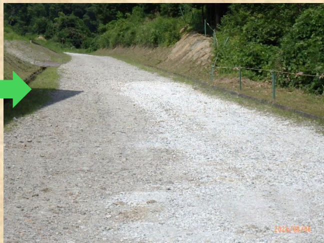
■ 碎石投入後平らに
