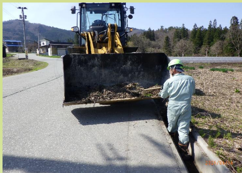
■側溝の泥上げ作業状況
