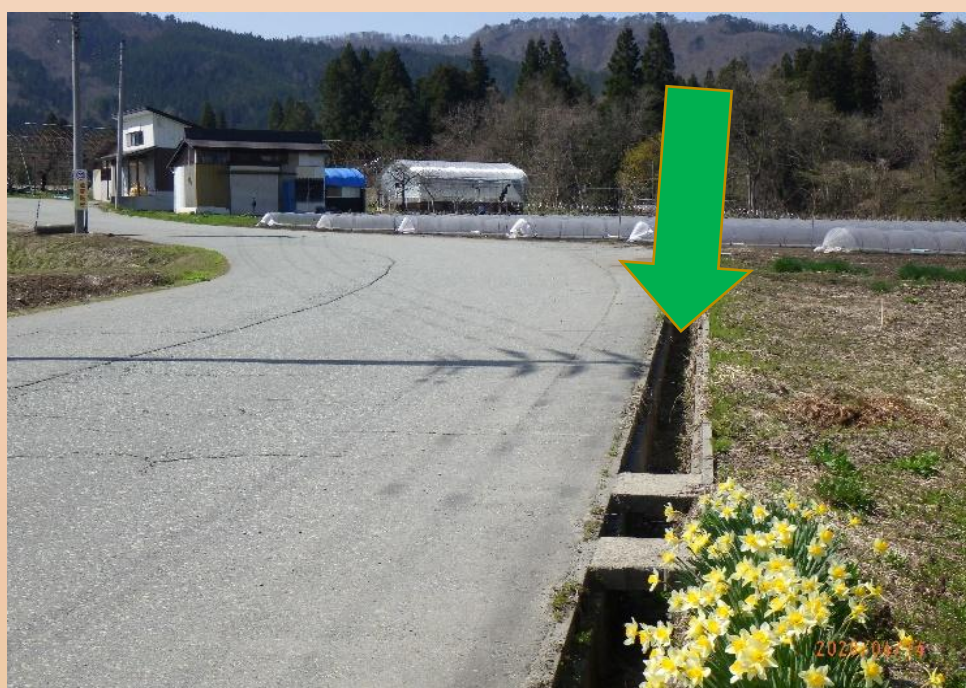
■村山市道宮下東線➡清掃した側溝
