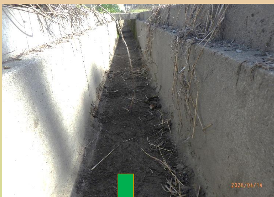
■清掃中の側溝
