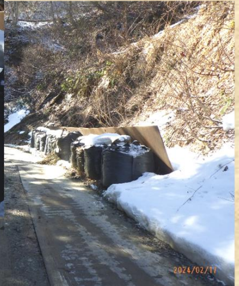
■劣化したフレコンの撤去後
