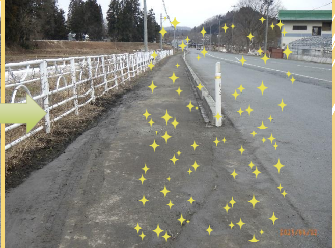
■ 清掃後 (きれいになった道路)
