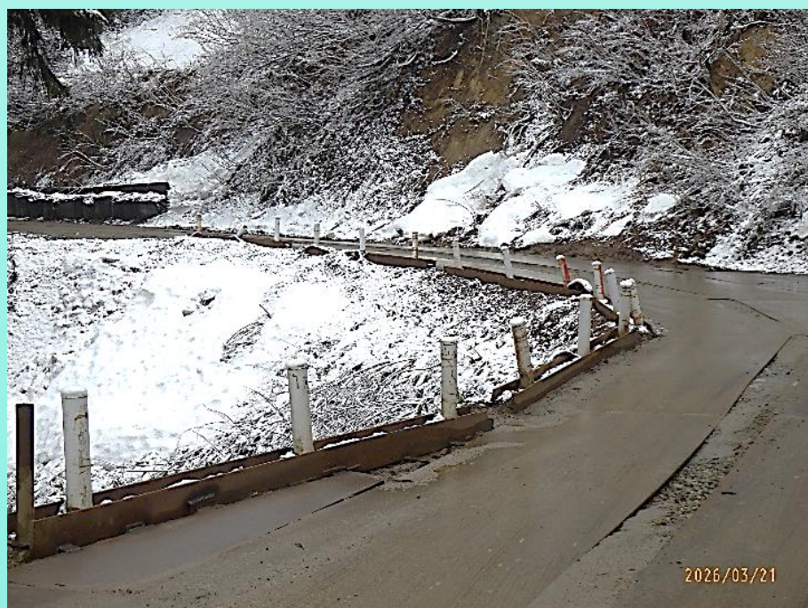
■ガードレール設置前
